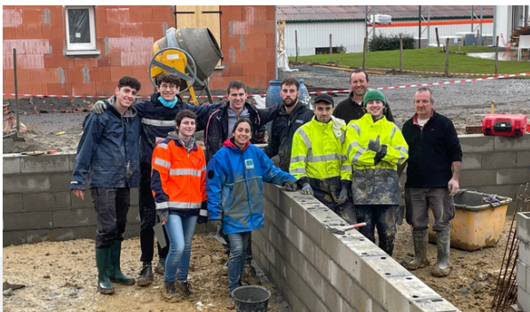
Formation de maçonnerie avec l'entreprise LERISSA
